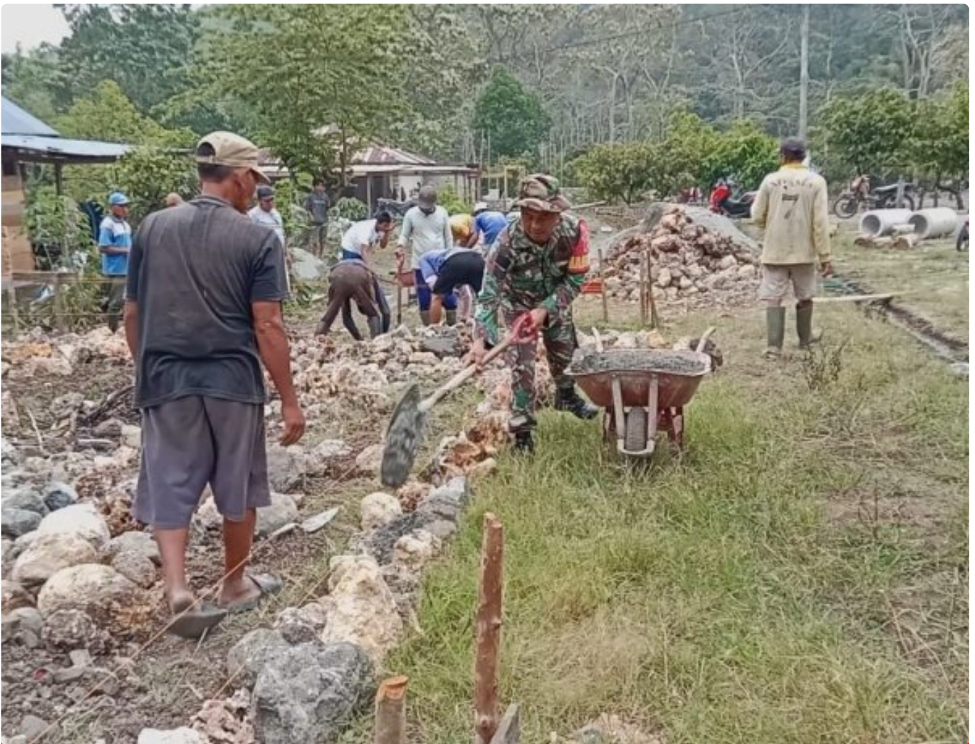
Gotong royong bangun pondasi rumah warga
